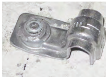
Фото правильно установленного крепежного элемента
