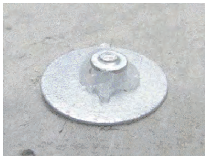
Правильно установленный гвоздь
