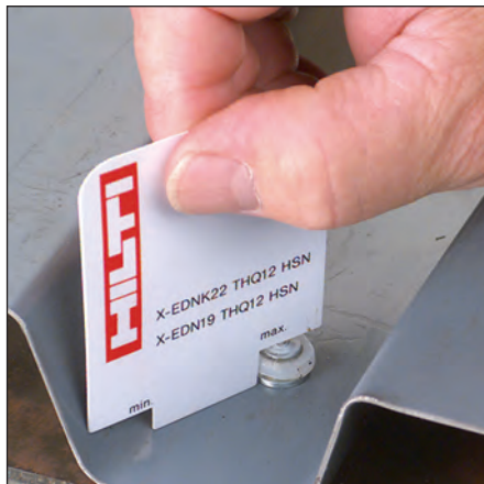
Проверка выступания гвоздя для кровли X-EDN 19 при помощи пластикового шаблона
