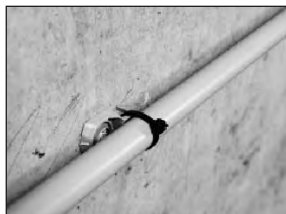
Крепление гибких или жестких кабелей кабельной затяжкой
