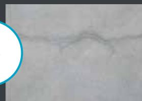
Без использования резки: Бетон подвержен значительному неконтролируемому растрескиванию.
