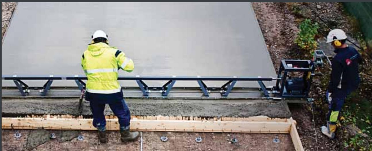
Виброрейка "ВТ90" — это чрезвычайно выгодное решение для уплотнения, выравнивания и отделки бетонных полов больших площадей, дорожных покрытий, взлетно-посадочных полос и мостов шириной до 25 метров
